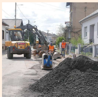
Travaux rue du Pont
