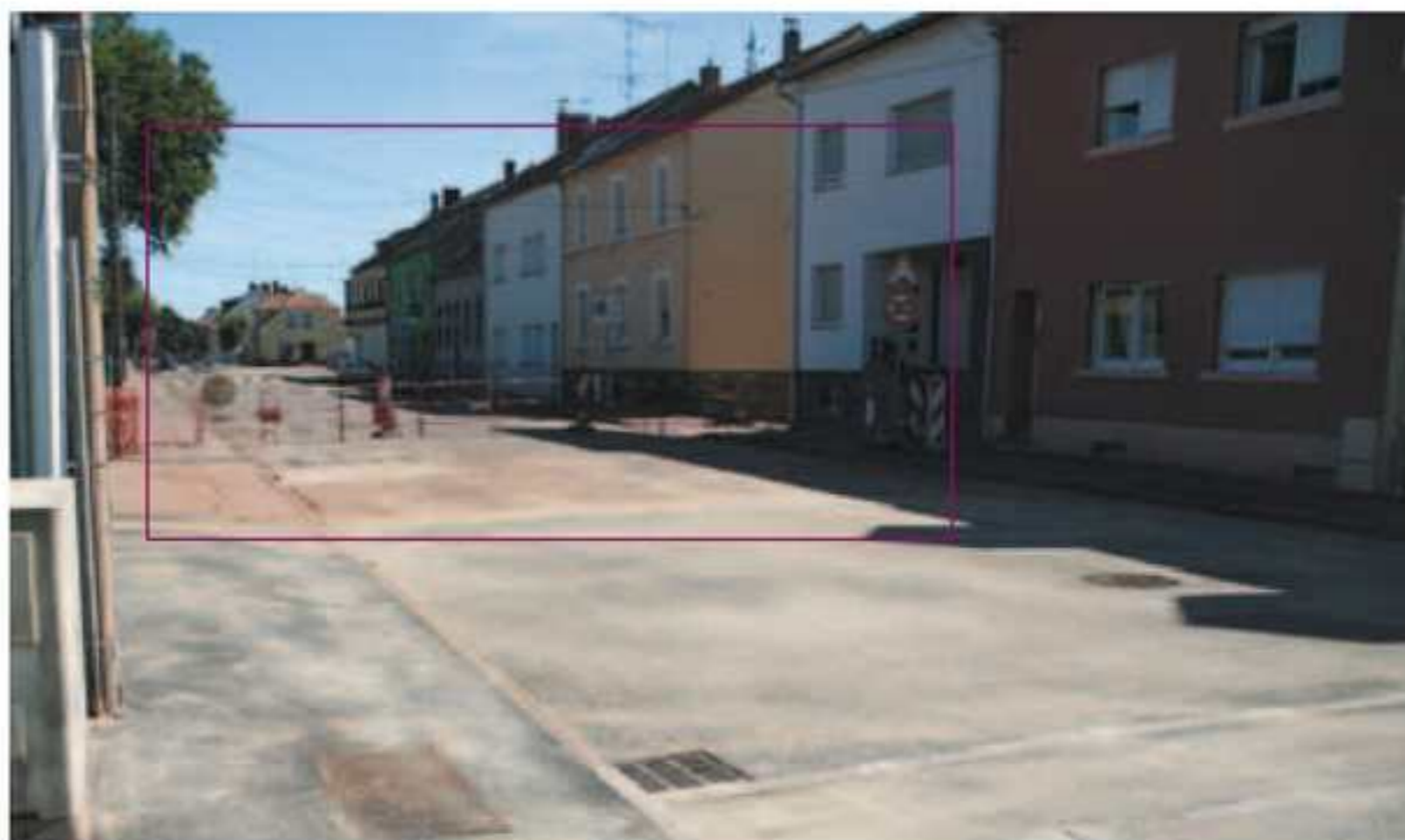
Assainissement avenue du Général Patch.
